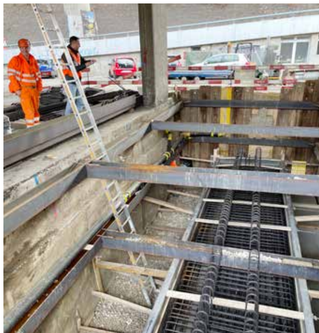
Fundamentsstruktur neuer Autobahn Pfeiler
