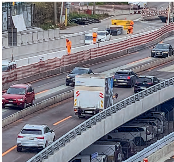
Arbeiten unter starkem Verkehr.
