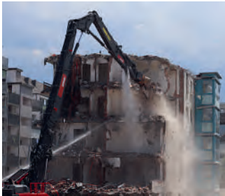
Der Rückbau im Frühjahr 2024.
