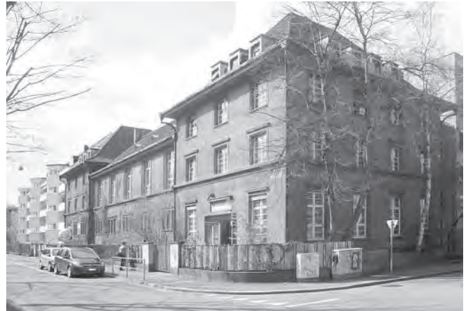
Altes Bad- und Waschhaus in der Breite. © Alban Rüdüsühli
