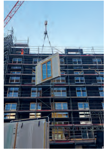
Montage der vorfabrizierten Elemente.
