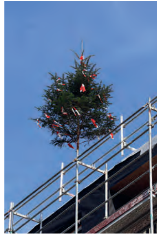
Seit September steht der Richtbaum.
